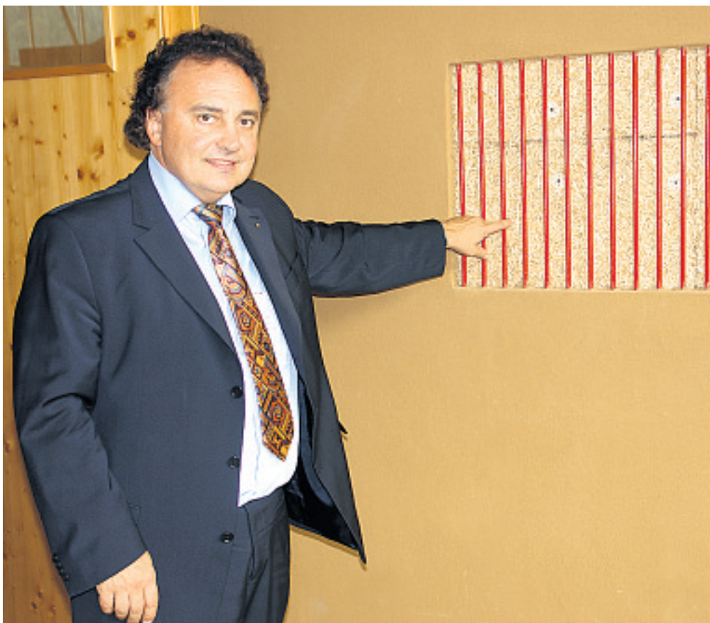
Dünne Kunststoffrohre in den Wänden sorgen für angenehme Strahlungswärme im Winter und Kühlung im Sommer, sagt Raimund Harreither. Foto: Rundschau
