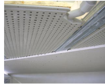
Von der glatten Gipsbauplatte über Akustikdecken bis zu Metall-Bandrasterdecken – die Modul-Klimatelemente können mit vielen Deckensystemen kombiniert werden.
