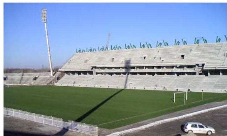
Im Stadion der ungarischen Mannschaft Györ hat Harreither bereits eine Heizung vom gleichen Typ installiert
