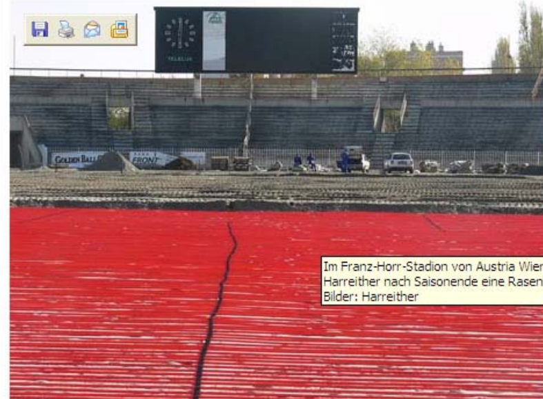
Im Franz-Horr-Stadion von Austria Wien verlegt die Firma Harreither nach Saisonende eine Rasenheizung Alle Bilder: Harreither
