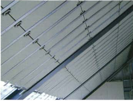
Vor allem bei Dachausbauten sind gerade im Sommer hohe Temperaturen ein Thema. Die Modul Klimadecke wirkt dem effizient entgegen.
